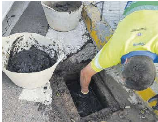
Un operario de Aqualia limpia un imbornal.
