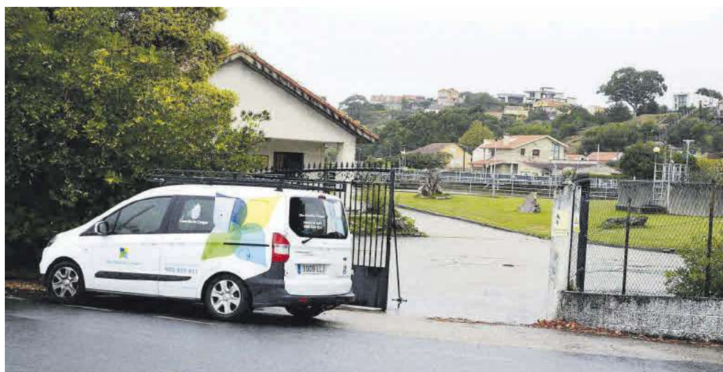
Entrada a la estación depuradora de aguas residuales (EDAR) de Balea-Areamilla, a donde llegan los residuos del municipio. | G.Núñez
